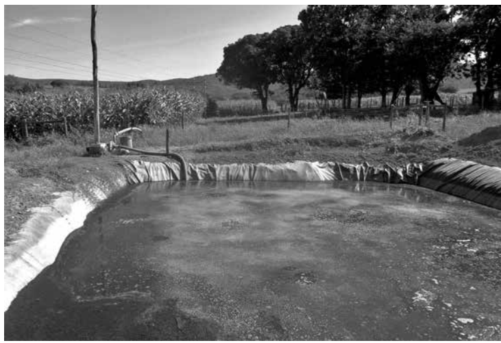
Tanque onde foi instalada a esterqueira
