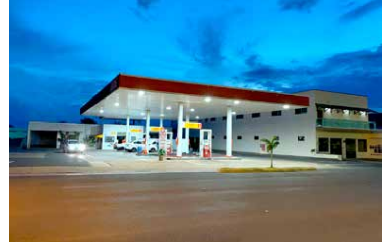
Autoposto Avenida I - Local de uma das geladeiras solidárias
