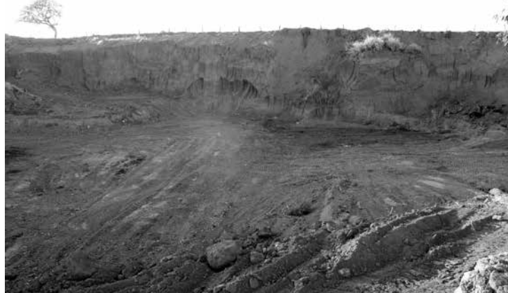
Local onde será construído o stand de tiros no CIISP
