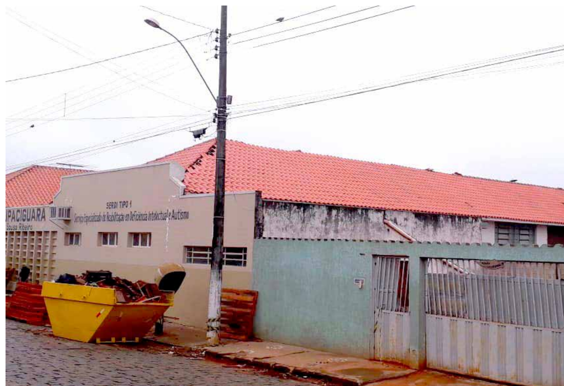
Reforma realizada no telhado da entidade, com o dinheiro repassado pela Câmara por emenda
