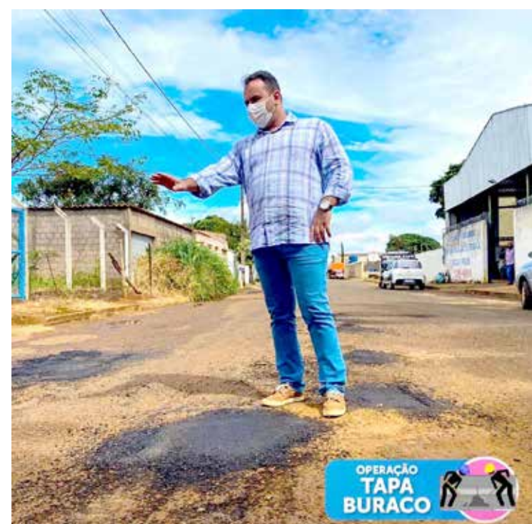
Prefeito Neto vistoriando pessoalmente o trabalho realizado
