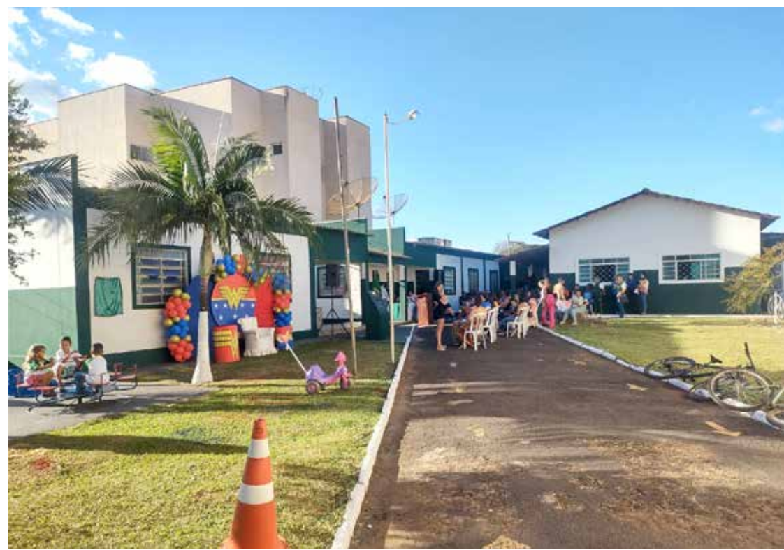
Vista das instalações do CEMEI
